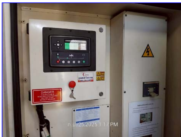
รูปที่ 2.24 เครื่องกำเนิดไฟฟ้าฉุกเฉิน
