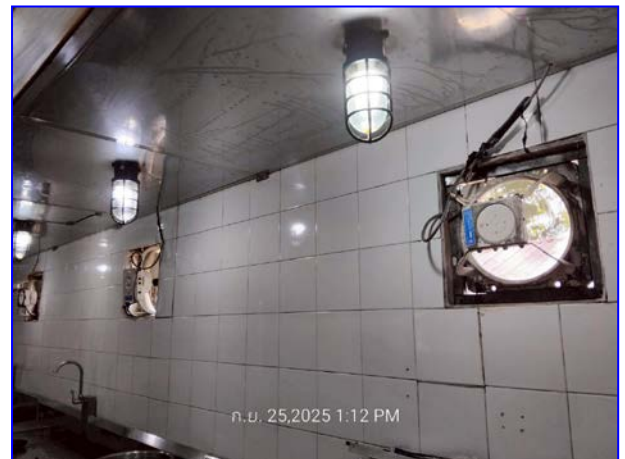
รูปที่ 2.22 ระบบระบายอากาศภายในห้องพักและห้องครัว
